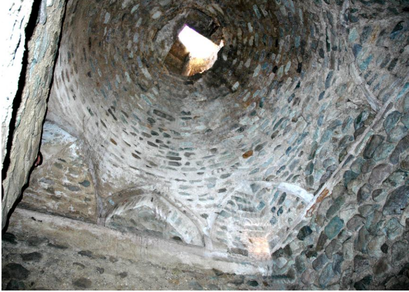
Şəkil 41. “Şıxəli xan” kəhriz-abidənin tavanın bir hissəsinin görünüşü.
