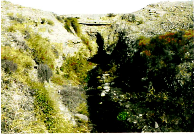
Şəkil 11. Naxçıvan şəhərinin şimalında «Canan bəy» kəhrizinin çıxışı.
