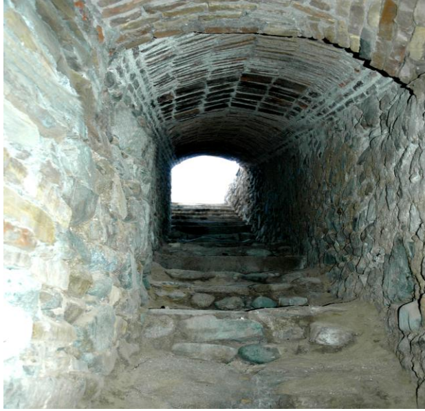
Şəkil 36. «Sərşəhər» məhəlləsində «qırxpillə»nin içərisinin görünüşü
