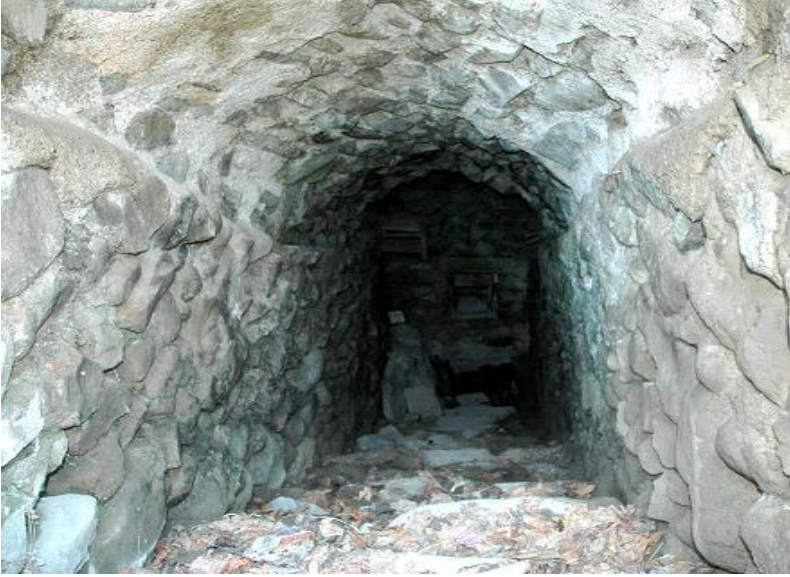
Şəkil 34. Yuxarı Əylis kəndində çay daşından inşa olunmuş qırxpillo
