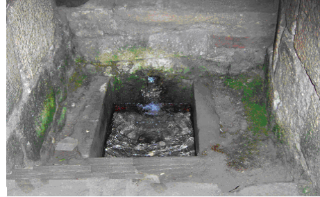
Şəkil 24. Yuxarı Əylis kəndi, «Quşlu çeşmə» üzərində inşa edilmiş qırxpillənin su götürmə hovuzu.
