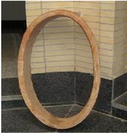
Şəkil 58. Kəhriz kürəsinə qoyulan beton həlqələr (İran)
