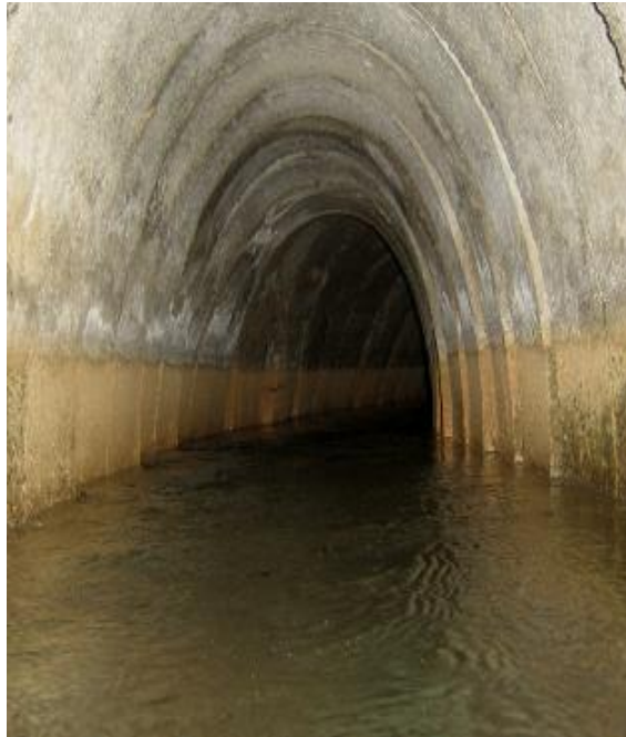
Şəkil 59. Kəhriz kürəsinə qoyulmuş beton həlqələrin düzülüşü (İran)
