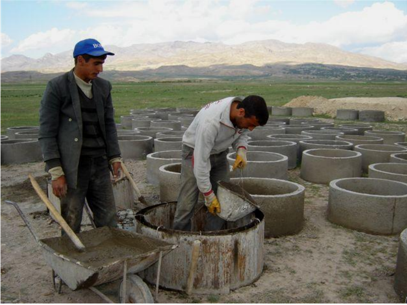
Şəkil 61. Quyular üçün hazırlanan beton həlqələr (Naxçıvan)
