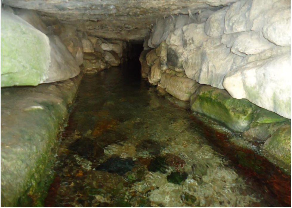
Şəkil 82. Kəhrizin çıxış hissəsi
