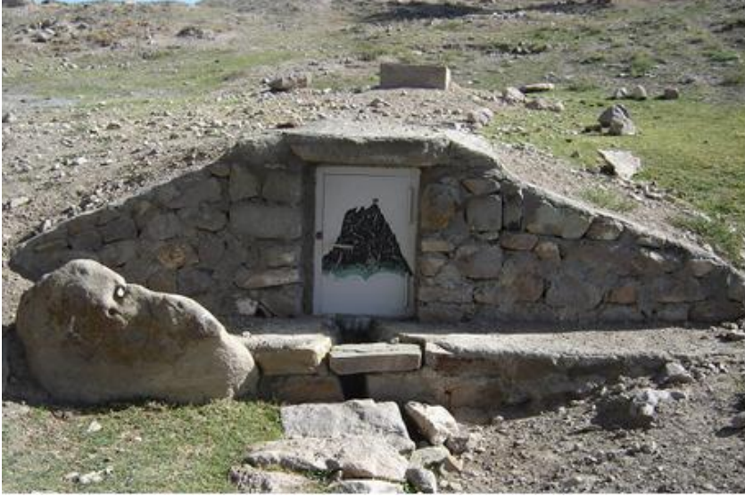
Şəkil 53. Kəhriz kürəsinin süni yolla kənar müdaxilərdən qorunması
